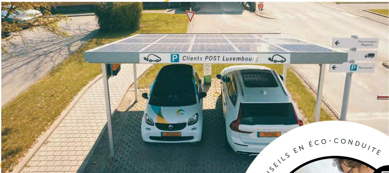
La particularité de la borne de recharge extérieure est d'être recouverte de panneaux photovoltaïques. L'électricité produite par les panneaux n'alimente pas directement les bornes mais est injectée dans le réseau de Creos.
